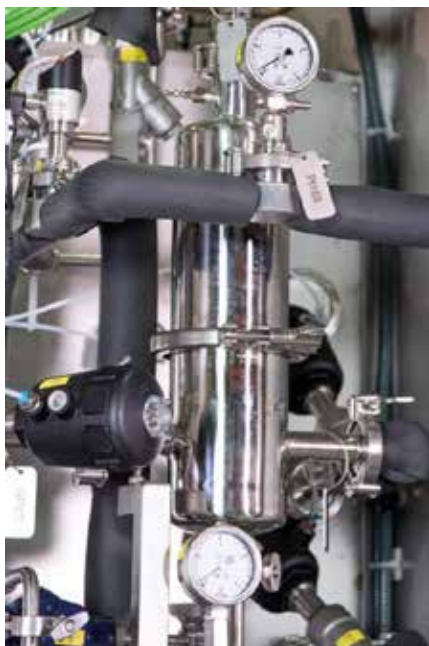
Figura 2. Filtro Hidrofóbico de alta eficiencia (0.22 \mu\text{m} ) encapsulado en carcasa de acero inoxidable. Este filtro está preparado para ejecutar un test de integridad del filtro (WIT) de manera automática.
